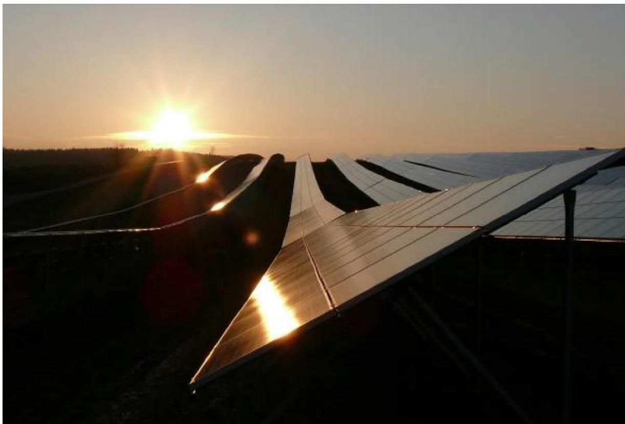
Bei steileren Winkeln über  $2^\circ$  kann es nur noch zu Teilreflexionen kommen, die mit zunehmend steileren Winkeln rasch abnehmen. Zugleich wird in dieser Phase das Sonnenlicht aufgrund der Neigung der Module, mit  $10$  bis  $25^\circ$  und deren Ausrichtung nach Süden bereits zunehmend nach oben in den erdfernen Bereich reflektiert.
