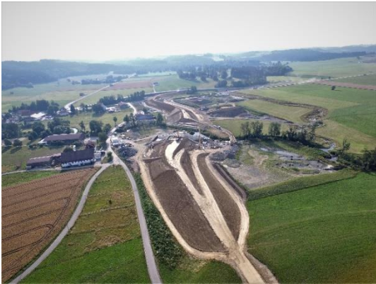
Das Hochwasserrückhaltebecken Eldern während des Baus, Quelle: WWA Kempten
