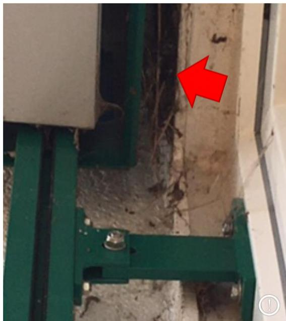
**G5** Spalt hinter aufgesetztem Rolladenkasten mit Nestbaumaterial (Grashalmen)
